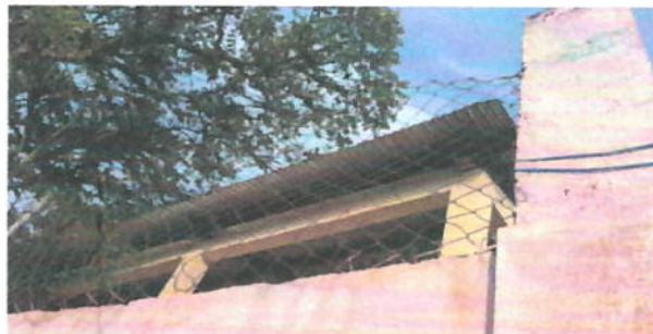
Foto 4: CERCO O MURO PERIMETRAL
