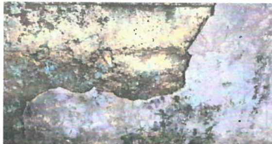
Foto 2: REPARACIÓN DE REPELLO Y CERNIDO DE PAREDES
