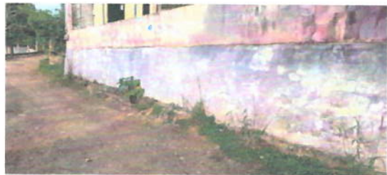
Foto 1: PINTURA EN MUROS INTERIOR Y EXTERIOR
