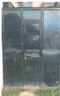
Foto 3: MANTENIMIENTO A PORTONES
